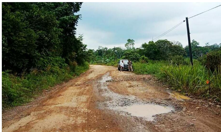
Peningkatan Jalan Poros SP. Muara Tokong – Simpang GBU (Sebelum di Semenisasi)
