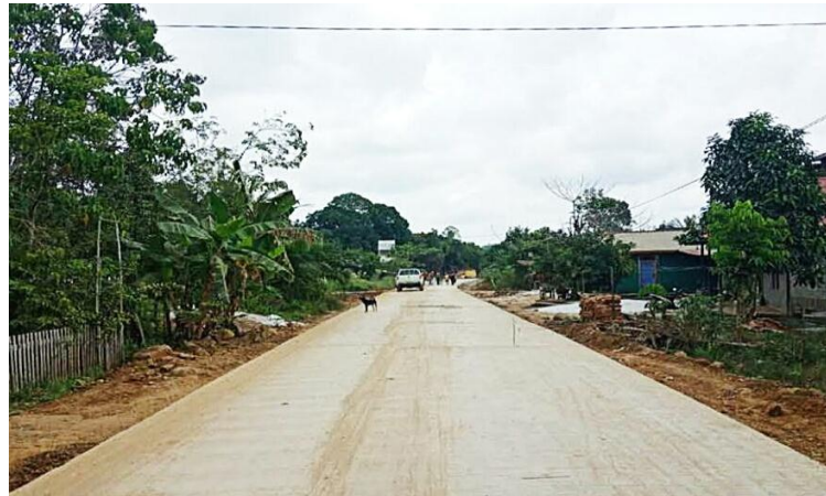
Peningkatan Jalan Poros SP. Muara Tokong – Simpang GBU (Setelah di Semenisasi)
